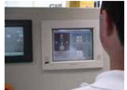
Start-up supervisor instalación ESA
