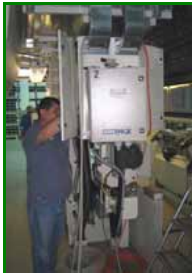
Installierung einer ACE Rotostatic
